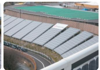
グローバル・ループから見ることでできる3種類の太陽光発電システム。現在主流の多結晶シリコン型(右上)、夏場の発電効率が高いアモルファスシリコン型(左上)、そして垂直に設置することで安定的な発電を可能にする単結晶シリコン型両面受光システム(下)。これらの太陽光発電システムは、合計で最大330kWの発電容量を備えている。
