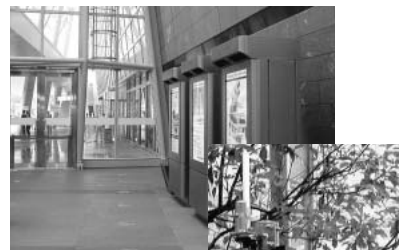
【A】ウエストウォーク内の掲示板。この中にアンテナが隠れている。
