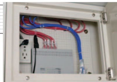
各部屋に用意された配線盤。青いのが「他回線専用」に用意された予備ケーブル(カテゴリ-5)だ。
