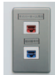
オレンジ色のRJ-45コネクタはサイバーホーム用、青いコネクタは他の回線用と2系統用意されている。
