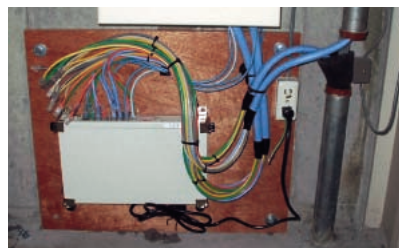
7階に設置したハブ。これのおかげで、1階のハブがすべてのイーサネットケーブルを束ねなくてもよくなり、細い配管にケーブルを通せるようになったと言う。
