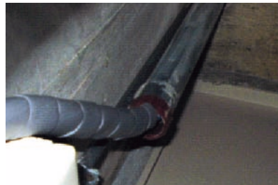
見えにくいかもしれないが、これが幕張ファミールハイツのブロードバンド化を後押しした、隠れ配管。
