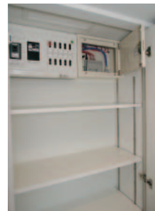
各部屋に用意された配線盤。青いのが「他回線専用」に用意された予備ケーブル(カテゴリ-5)だ。
