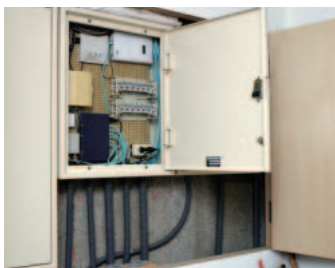
稲岡邸の配線盤。日東工業の大きなボックスが3つ並び(左は電源、右はテレビ用)、中央のLAN、電話用の配線盤には各部屋にスター型でつながる配管が5本ある。
