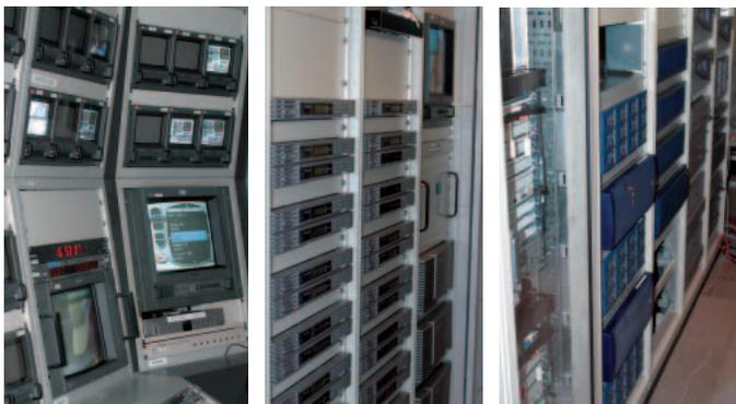
ビービーケーブルの社内には左写真のような機器が備えられている。左から、コンテンツの配信状態を監視する監視システム。番組をMPEG化するエンコーダー。VODのコンテンツが蓄積されているVODサーバーだ。
