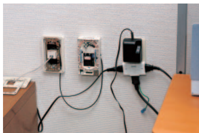
電話用のモジュラーパネル(左)から光ファイバーをメディアコンバーター(真ん中)に接続する。
