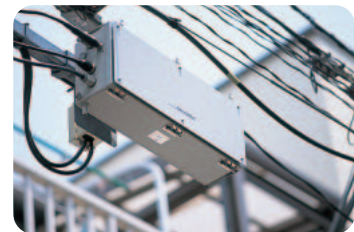
スピードネットの無線サービスに用いられるアンテナ。電線にそのまま取り付けられている。
