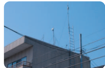
アルターネットで使用している無線LANのアンテナ。写真店の屋上に設置されている。
