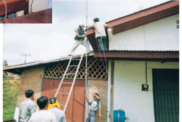
ラオス診療所のアンテナ設置工事
