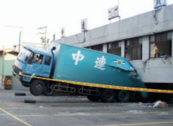
●台中県大里は被害が多く、多数の建物が倒壊した
