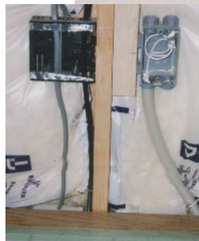
壁材を入れる前の、まさに配管途中のところ。
