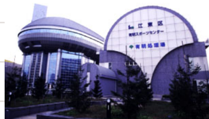
有明処理場。建物上部はスポーツセンターになっている。後案ポンプ所の上に20階建てのビルを建築する予定など、下水道施設の丈夫さを活かした活用も進んでいる。
