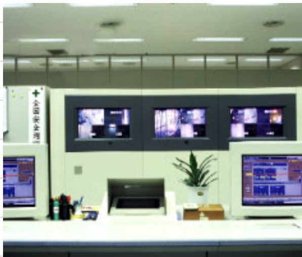
計7つのポンプ所の情報を光ファイバー網で結び、ここで一括管理している。
