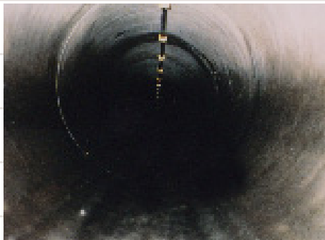
ロボットが通ったあとには、光ファイバークーブルがしっかりと取り付けられている。1994-2007 Impress R&D
