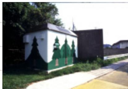
長田交差点(長田区北町)のコンビニ前の歩道の一角に、濃茶に塗られた中容量RTボックスのひとつが。800回線を収容する「超小型RTボックス」。公園などに置かれる公衆電話併設型もある。
