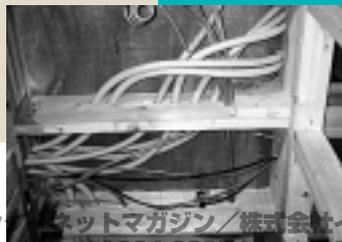
**配**管とは家のどこにあるのだろうか。これは、右図のように壁と外壁の間にある隙間を通じて家中に引き回される。配管に使うチューブは洗濯機の排水ホースのようなもので、くねくねと自由に曲げられるので家のどこにでも取り回すことができる。
