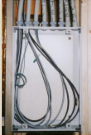
1階の情報分電盤の工事の様子。配線の種類ごとに配管があることがわかる。
