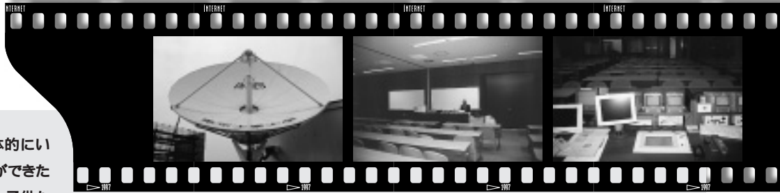
通信衛星システムANDESのパラソラアンテナ。直径4.5mの大口径アンテナだ。
