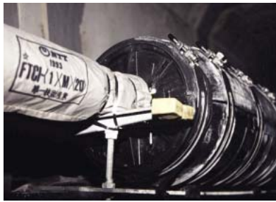
③ ケーブルのつなぎ目。この中には、3600本の銅線が正確につながっているのだ。
